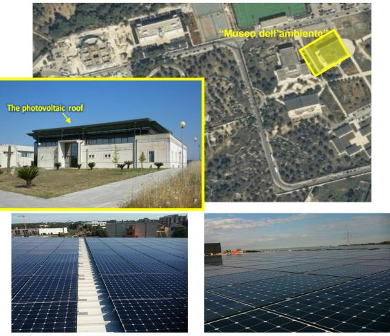
Figure 57 the photovoltaic roof on "Museo dell'ambiente"
